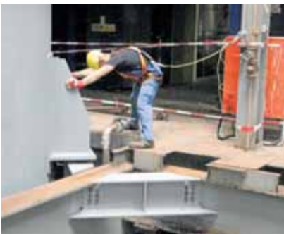
Fürs Feinjustieren des Verdampfers ist auch Handarbeit gefragt.
