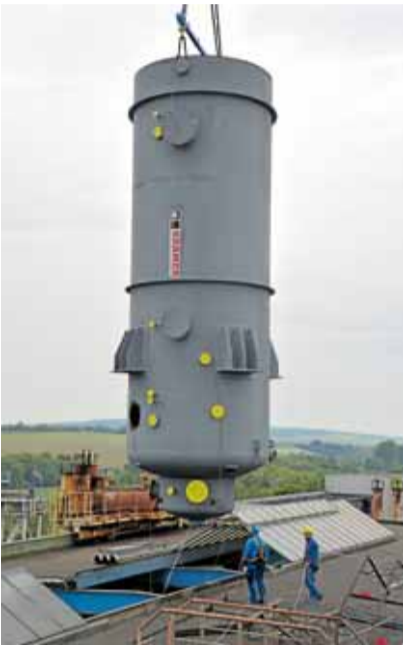
Durch die Dachöffnung wird der neue Verdampfer gleich herabgelassen.
