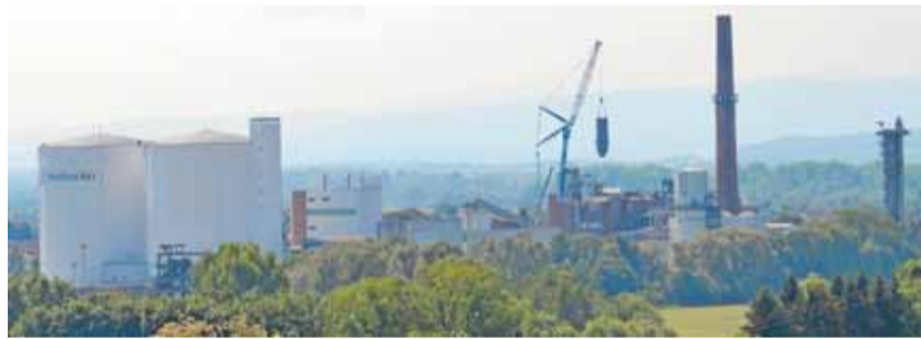
Über der Zuckerfabrik schwebt am weithin sichtbaren Kran der tonnenschwere Verdampfer, der gleich in die Werkhalle abgeseht wird – Millimeterarbeit.
