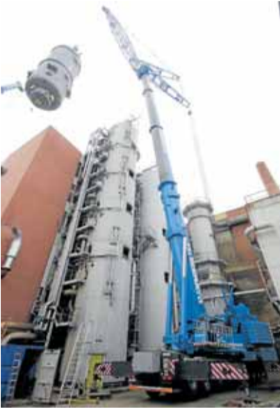
Im Innenhof hievt der große Kran den Stahlkoloss in die Höhe.
